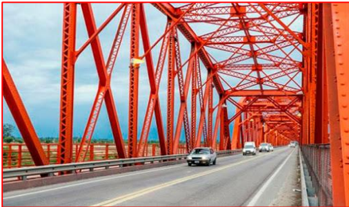
Puente Carretero, Santiago del Estero
